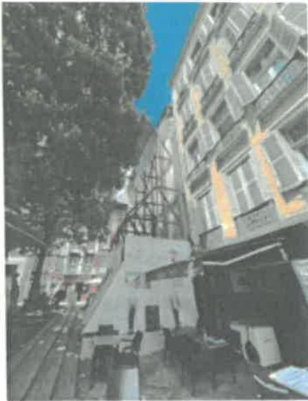
Immeuble renforcé en façade par une structure métallique
