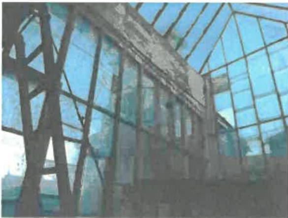
Immeuble renforcé en façade par une structure métallique
